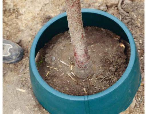
Abbildung 6a: Einbau arboGreenWell™ einteilig
